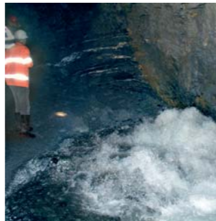
Karstquelle im Tunnel Flims
